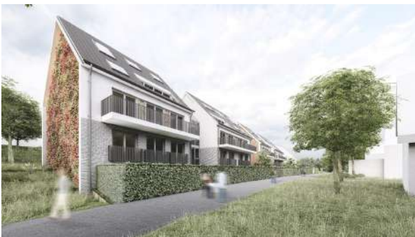
Ansicht Vorbergstraße Haus 4
