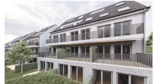
Ansicht Vorbergstraße Haus 1
